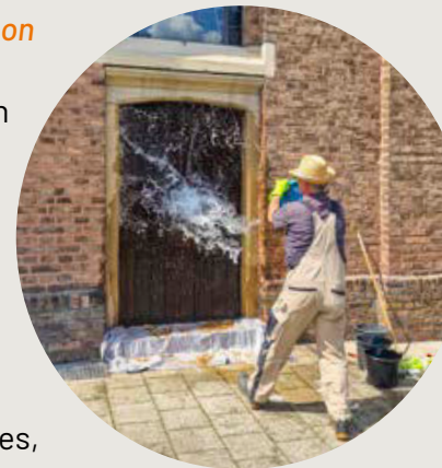
Nach dem Einpinseln kommt das Wasser mit Schwung auf die Tür.
